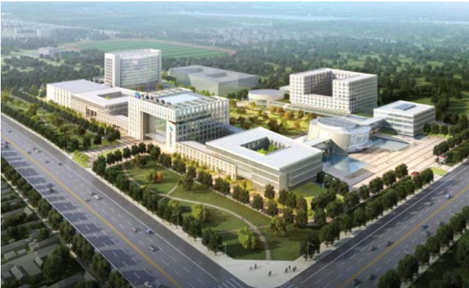
▲ 马坡主生产中心俯视图
